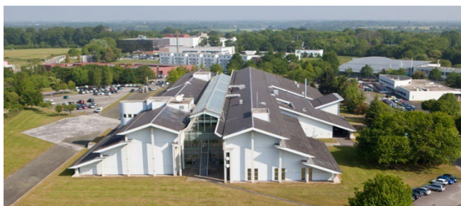
De gauche à droite : bâtiment ISITEM, bâtiment IHT, bâtiment IRESTE
