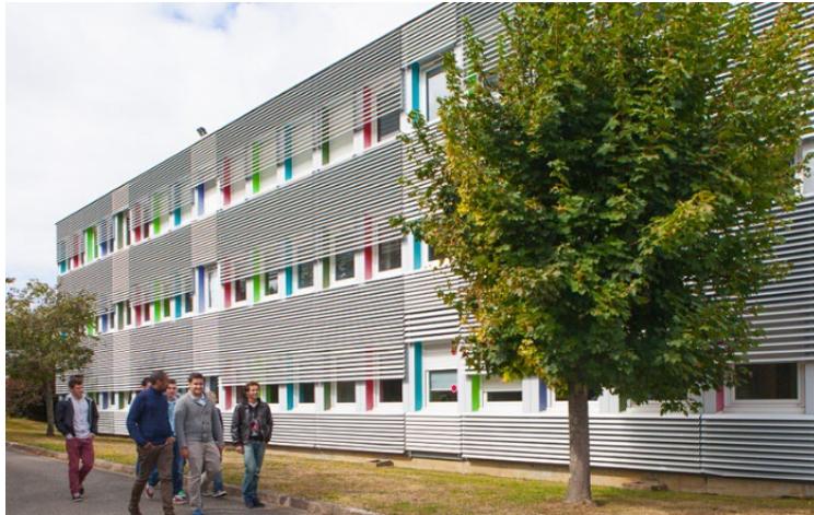
Bâtiment d'enseignement site Heinlex
