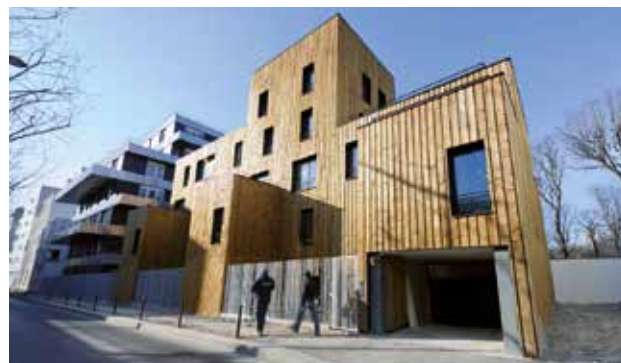
Des opérations de rénovation urbaine (ici à Paris) prennent toute leur place dans une approche environnementale de l'urbanisme.
