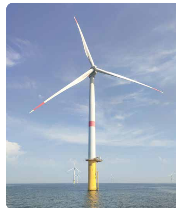
Parc éolien en mer de saint-nazaire - © Alice Mazaré
